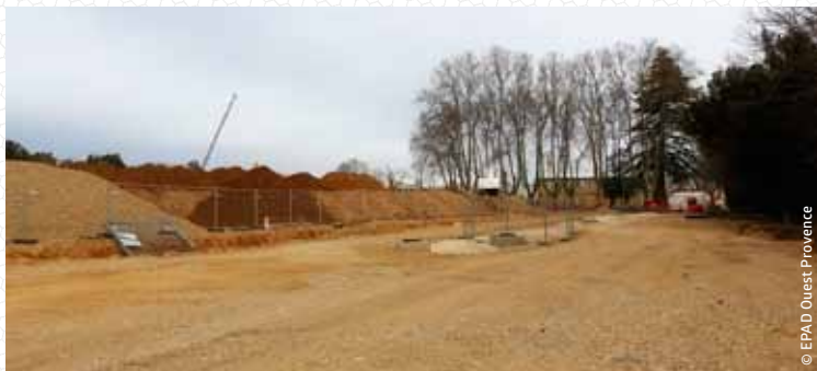
La ZAC de la Péronne a fourni des matériaux inertes, entre autres pour le chantier de déviation de la Dreal Paca.
