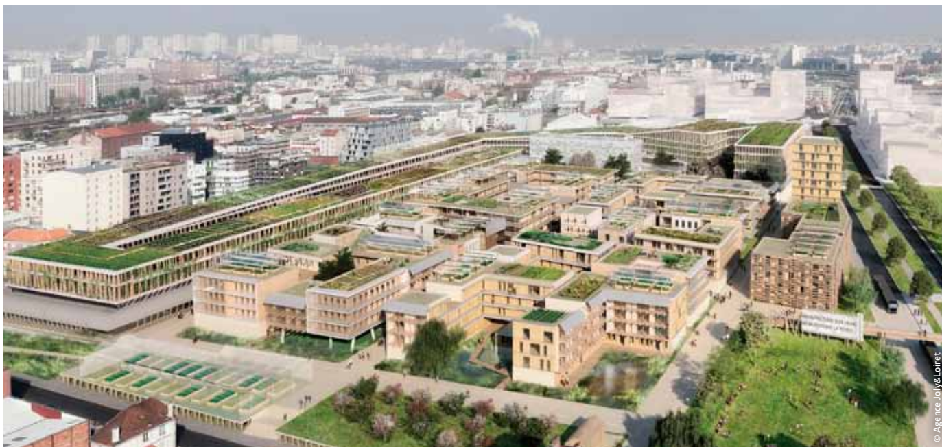
Lauréat de l'appel à projets « Réinventer la Seine 2017 », le quartier de terre d'Ivry-sur-Seine devrait être construit d'ici à 2024 avec les déchets inertes du Grand Paris Express.
