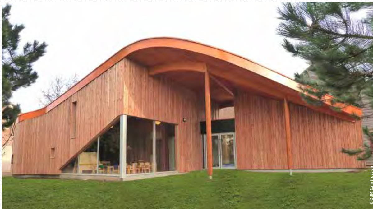
Centre multi-accueil « Le Petit Prince » à Saint-Nom-la-Bretèche : Structure, couverture et bardage entièrement constitués d'éléments en bois.
