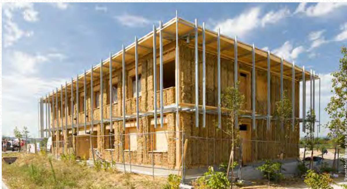
Bâtiment de bureaux à énergie positive d'Izuba énergies à Montpellier : Ossature bois isolation paille.
