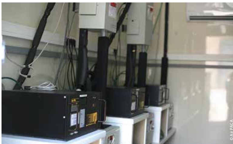
Station de mesure de pointe installée au cœur de Marseille.
