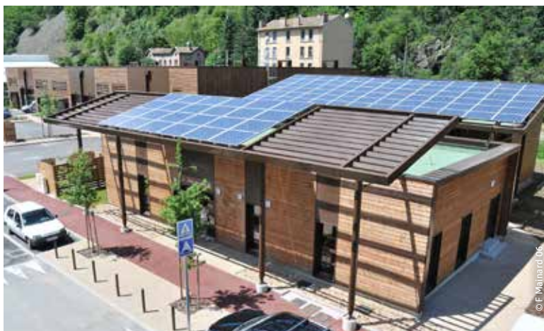
Des panneaux solaires ont été installés par la communauté d'agglomération de l'Ouest Rhodanien lors de la construction de la pépinière d'entreprises de Tarare. D'autres bâtiments publics seront équipés d'ici à la fin 2018.
