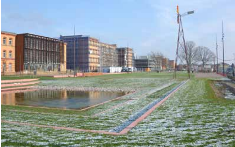
Écoquartier Thurot en construction.
