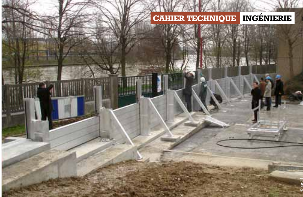
Pose de batardeaux pour protéger l'usine d'eau potable de Choisy-le-Roi lors de la crue de juin 2016.
