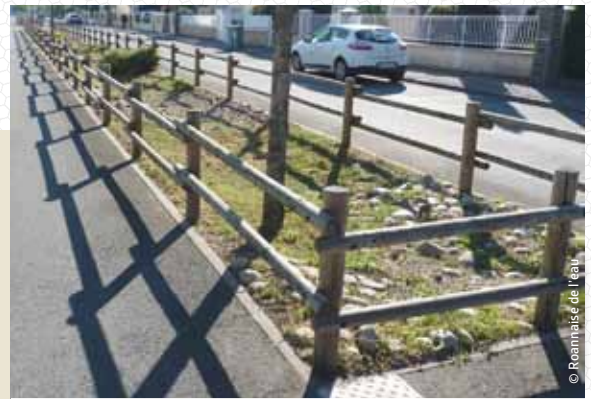
Création d'une noue au milieu de la chaussée à Riorges.
