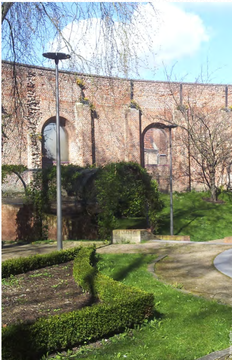
Luminaires d'éclairage extérieur à leds se trouvant sur le site des jardins de la Fonderie à Douai (Nord).
