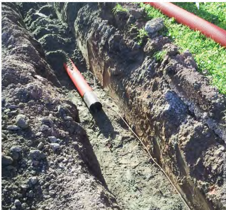
Pose d'infrastructure pour l'éclairage extérieur en tranchée.
