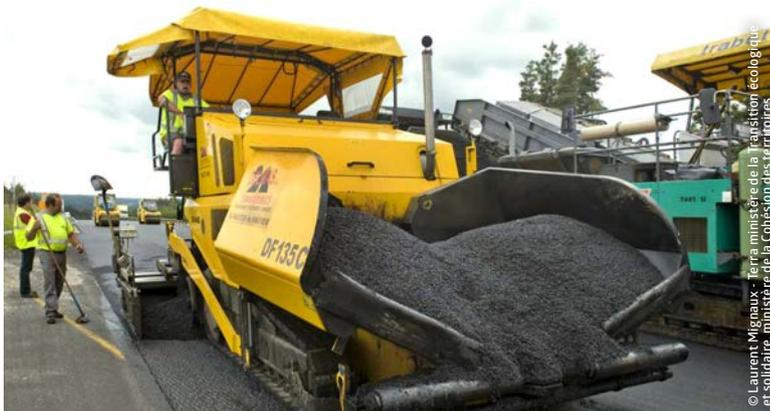
Chantier d'enrobé autoroutier en Lozère. Le taux de réintroduction des agrégats d'enrobés dans les enrobés bitumineux est passé de 5,8 % en 2009 à 12,9 % en 2014.
