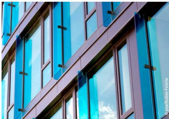
La mise en place de BSO provoquant des ruptures de la couche d'étanchéité de la façade, une étude pour définir le mode opératoire et les solutions techniques appropriées est nécessaire.
