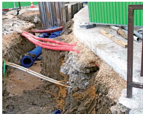
Réseaux électriques dont la pose ne respecte pas les règles de sécurité : faible profondeur, absence de grillage avertisseur et de matériaux d'enrobage.
