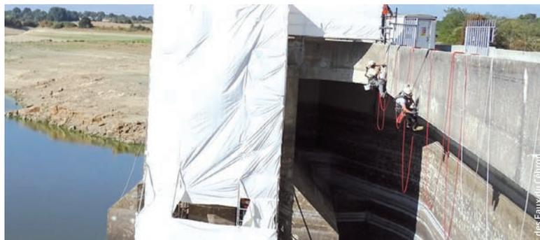
Pendant les six semaines d'assec du lac de Cébron, une inspection complète de tous les ouvrages a pu être réalisée, complétée d'une rénovation de certains équipements et canalisations.
