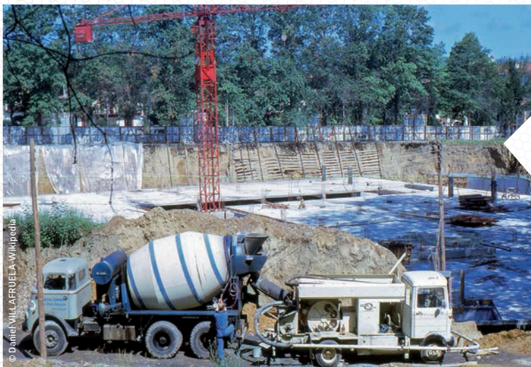
Construction du parking souterrain de la promenade Paulmy (ville de Bayonne, Pyrénées-Atlantiques).
