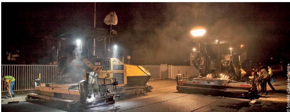
Pendant les différentes phases de travaux, la circulation a été alternée lors des opérations de rabotage et des applications d'enrobés.
